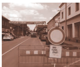
Další opravená komunikace...
