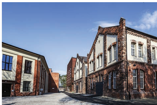
Důl Hlubina – Stavba roku ČR 2015. Archiv Stamont - Pozemní stavitelství
